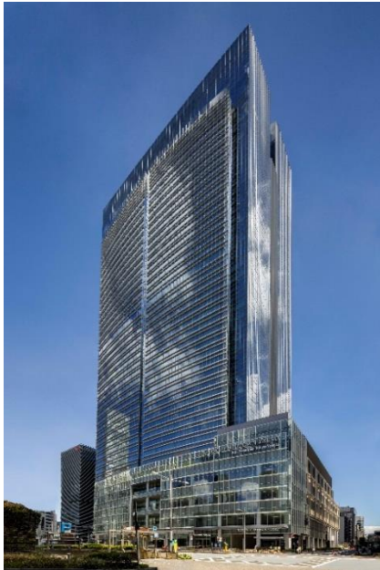
東京ミッドタウン八重洲 外観
